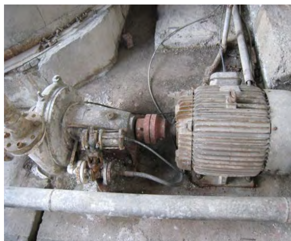
照片 6：會旋轉的馬達機具沒有防護罩罩住。
